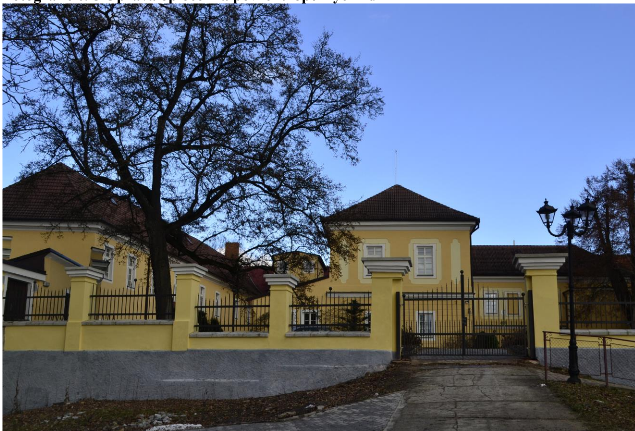
Fotografie č. 8 Oprava oplocení a povrchu opěrných zdí
