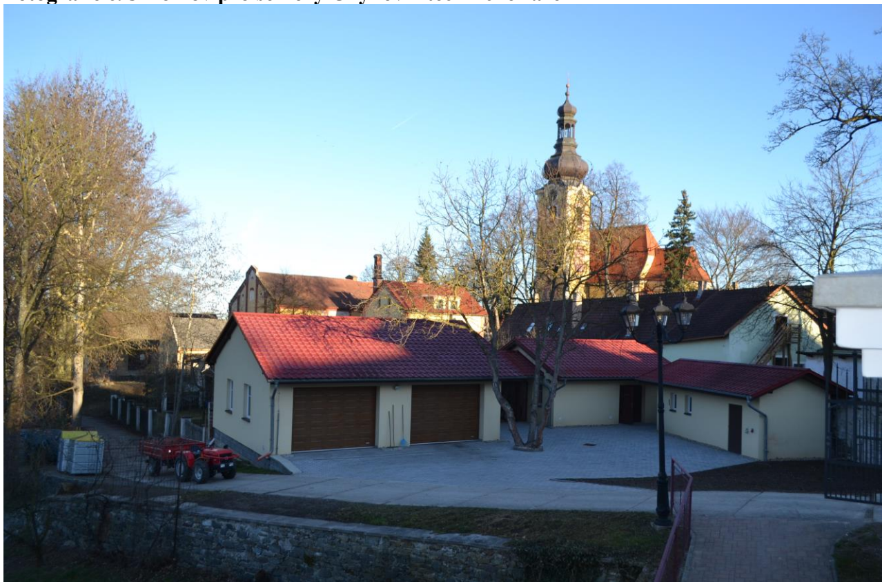
Fotografie č. 9 Domov pro seniory Chýnov – technické zázemí
